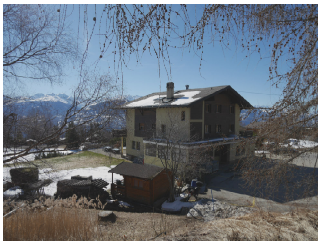
Figure 7 : vue sur la construction (restaurant) sise sur la parcelle n°2132
